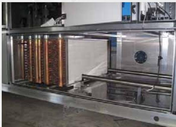
Particolare camera di umidificazione e batterie di trattamento con vano tecnico superiore per contenimento valvole e circuito sistema di recupero
