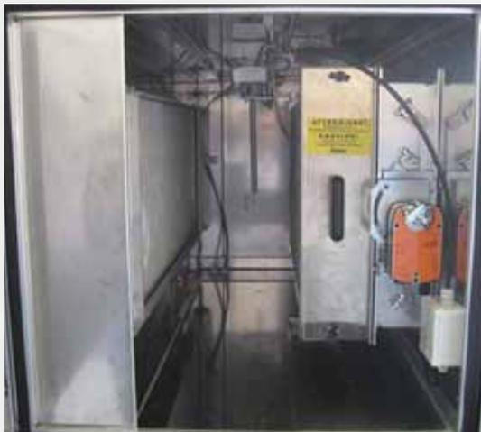
Particolare sezione di ripresa con batteria di recupero
