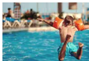
VILLA GLICINI POOL N. 2 AHU - 40.000 m³/h Pinerolo (IT)
